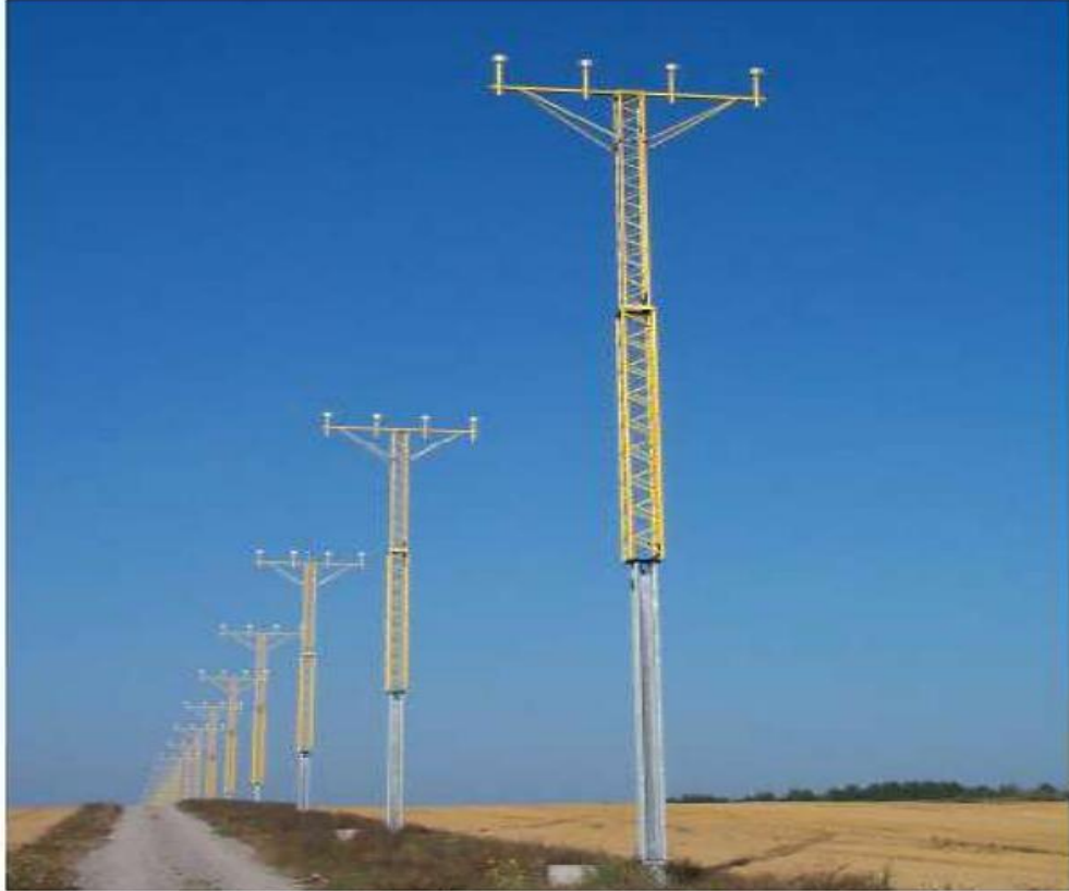
Figura 2-8-1. Torres de iluminación de aproximación de fibra de vidrio sobre estructuras de soporte rígidas.
